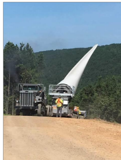
Photographie 33 : Utilisation d'un blade lifter sur un chantier RES aux États-Unis
