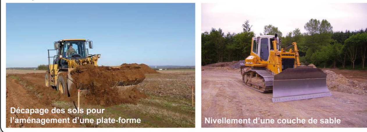
Photographie 35 : Exemples d'engins de travaux de VRD
