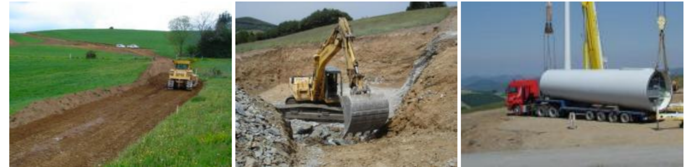
Photographie 48 : Illustrations d'un chantier éolien
