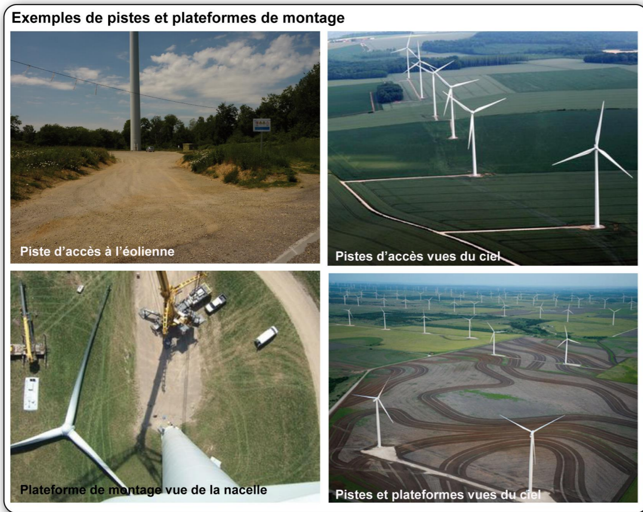
Photographie 30 : Exemples de plateformes de montage et de pistes (Source : ENCIS Environnement)
