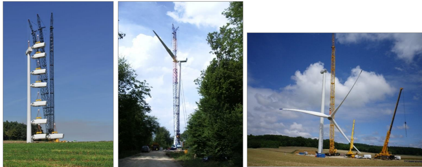
Photographie 40 : Levage et assemblage de la nacelle, des pales et du rotor (Source : RES)
