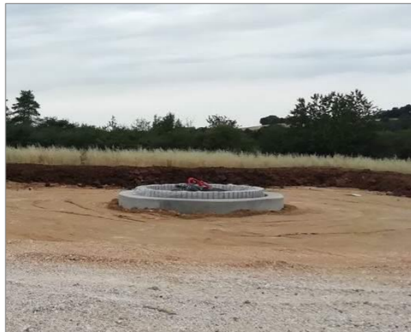
Photographie 37 : Fondation achevée et enterrée (Source : RES)
