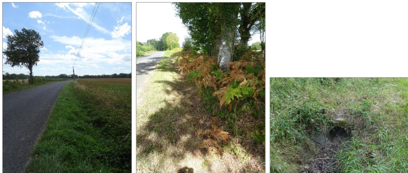
Photographie 44 : Fossés et buse observés le long de la RD63 (Source : ENCIS Environnement)
