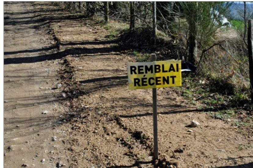
Photographie 43 : Exemple de remblai des tranchées électriques le long d'une piste (Source : ENCIS Environnement)
