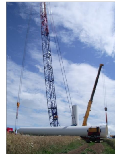
Photographie 39 : De gauche à droite : montage du mât ; fixation du premier élément ; levage et assemblage des autres tronçons du mât (Source : RES)
